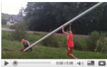
MONTAŻ KOMPOZYTOWYCH SŁUPÓW TELETECHNICZNYCH
