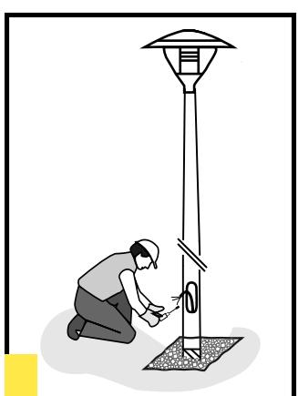
9 Podłączenie przewodów zasilających do słupa, podłączenie złącz elektrycznych, zakręcenie.
